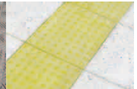
点字ブロック
